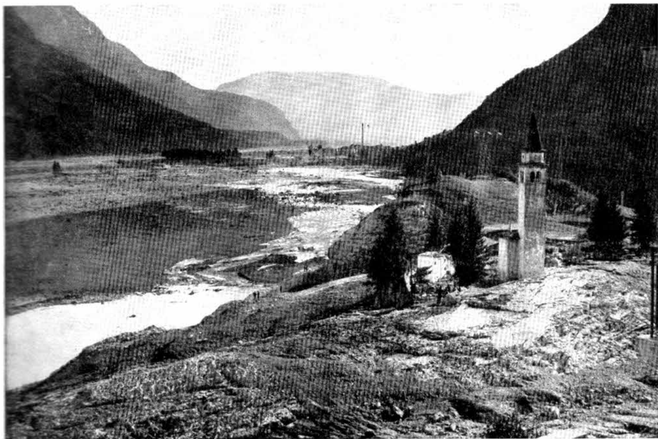
La valle del Piave livida e stanca dopo la sciagura. Tre soli manufatti risparmiati dal disastro, come tre simboli di una vita che deve riprendere e continuare: in primo piano, l'esile campanile di Pirago, segno di pietà e di fede; dietro, un traliccio per il trasporto della corrente ad alta tensione; in fondo, la ciminiera dello stabilimento Faesite, isola di lavoro risparmiata dalla distruzione
