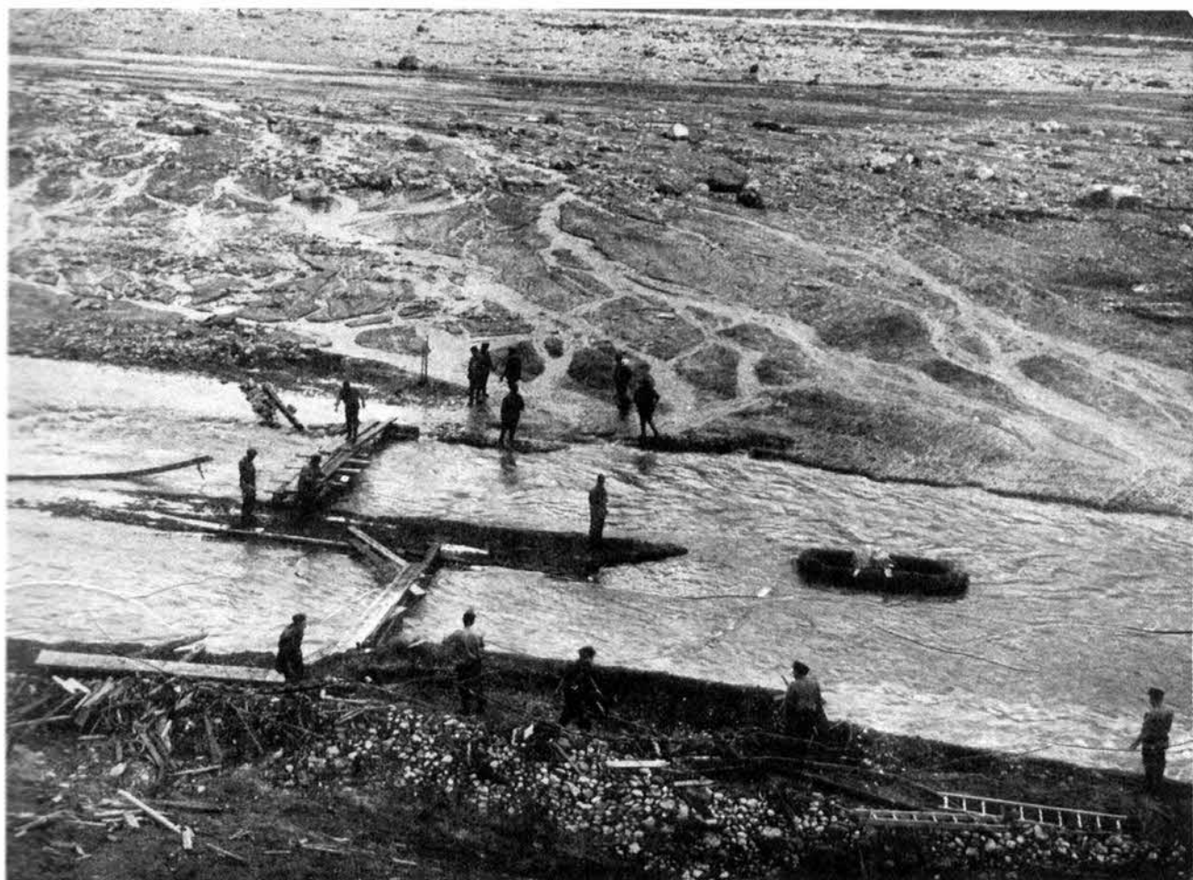
Le frazioni di Codissago, di Sogna e di Provagna, sulla sinistra del Piave, rimasero isolate per l'avvenuta distruzione dei ponti. Una delle prime iniziative dei V.V.F. fu quella di sistemare opportune passerelle per ristabilire un collegamento con quelle popolazioni
