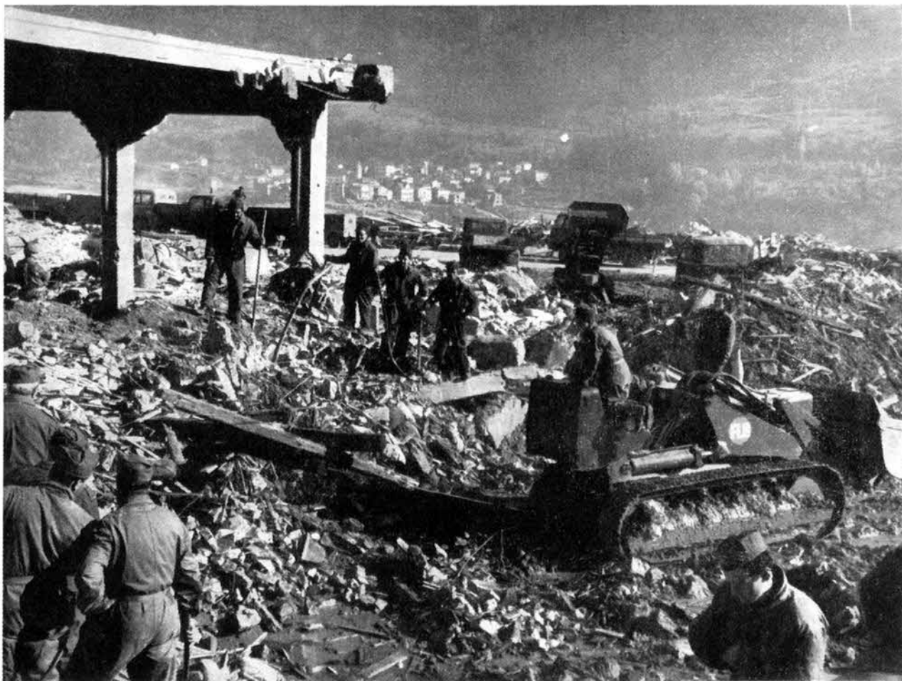
Longarone centro, 10 ottobre: i Vigili del Fuoco rimuovono le macerie in prossimità della sede distrutta del distaccamento pompieristico di Longarone. Il paese che si intravede sullo sfondo è la parte alta di Codissago risparmiata dalla distruzione
