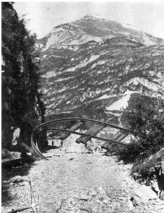
Ciò che può fare l'acqua, la casta e mansueta acqua, quando s'infuria: piega e spezza le sbarre d'acciaio come fossero fucelli
