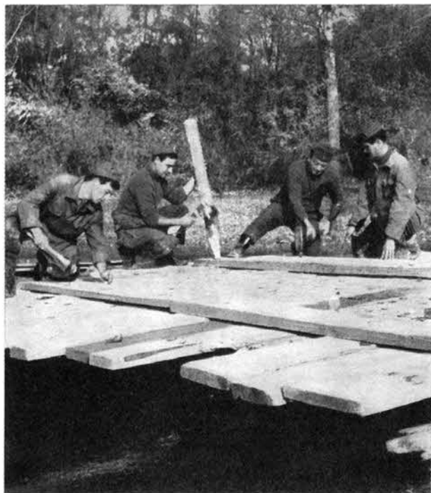
Vigili del Fuoco in funzione di carpentieri e di pontieri, compito in cui si sono rivelati maestri in questa circostanza
