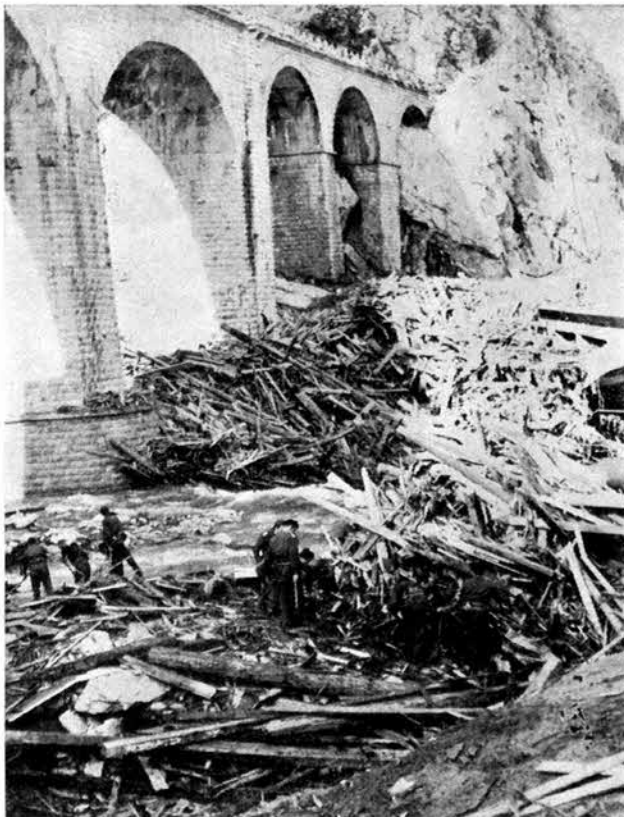
Il letto del torrente Maè, sotto il viadotto della ferrovia, era stipato da un'enorme catasta di legnami e detriti. All'opera di sgombero stanno prodigandosi i Vigili Volontari di Fiera di Primiero e i Vigili permanenti di Trento
