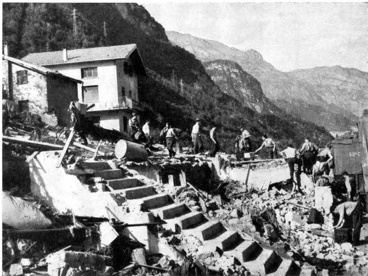
Ultime distruzioni della valanga d'acqua, in località Faè, a sud da Longarone centro: dopo una corsa di 4 chilometri la valanga d'acqua aveva ancora tanta forza da spianare un intero gruppo di case. I Vigili del Fuoco qui al lavoro appartengono al Comando Provinciale di Milano
