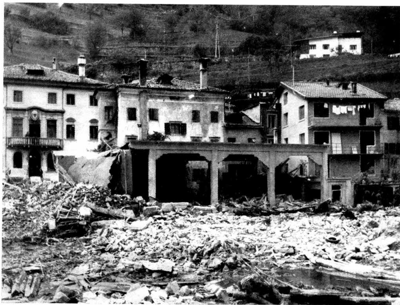
Questo è il nucleo di edifici risparmiato dal cataclisma. A sinistra il palazzo Municipale; al centro, in primo piano, sorgeva la sede del Piccolo Posto V.V.F. di Longarone, anch'essa, come si vede, sacrificata e polverizzata
