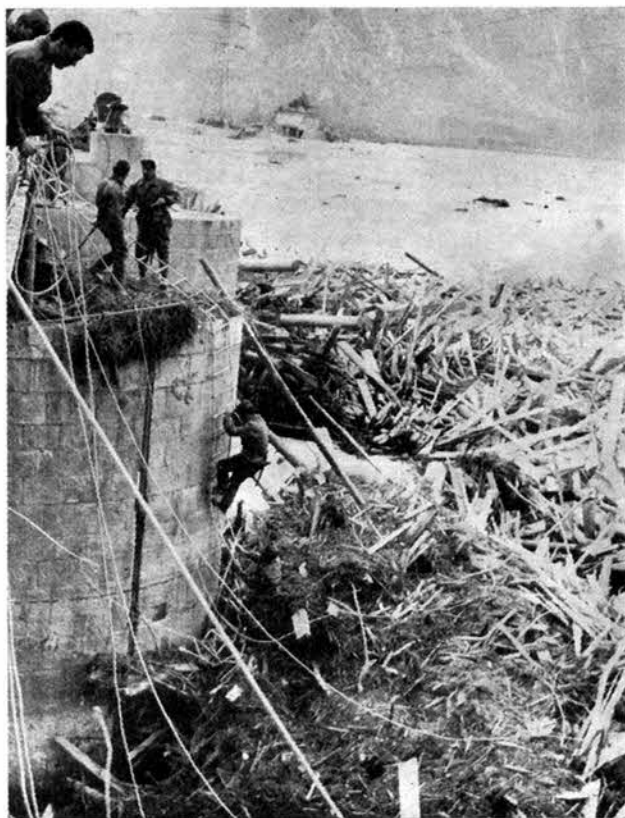
Migliaia di metri cubi di legname trascinati dall'ondata di piena hanno trovato il loro punto di intasamento al ponte-diga di Soverzene, ostruendo le luci di scarico della diga stessa. I Vigili del Fuoco stanno sgomberando un pilone
